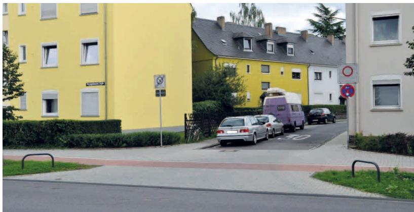
Abbildung 24: Aufpflasterung im Einmündungsbereich in Trier 77
