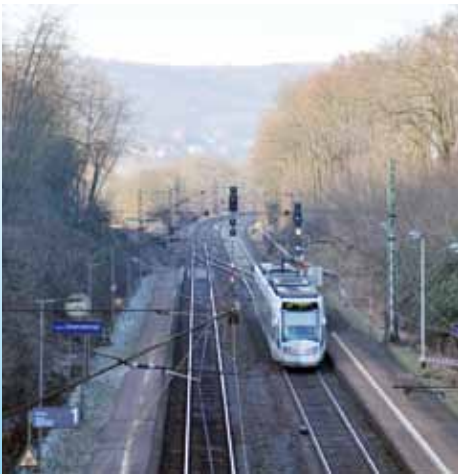
Noch gibt es in Obervellmar nur zwei Gleise
