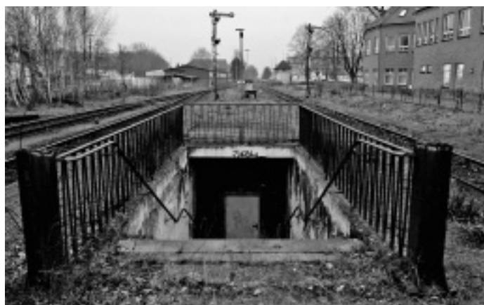
Kein Ausgang: Vom Sulinger Bahnhof, hier der Blick zum Gleis Richtung Rahden, ist nicht viel übriggeblieben. Die einstige Bahn-Unterführung wurde zugemauert.
