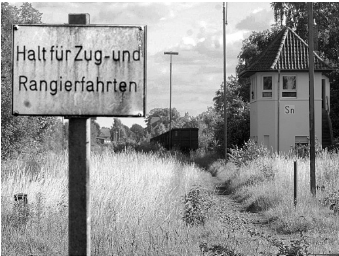
Wildwuchs: Gras wächst auf den Gleisen im Sulinger Bahnhof. Vom früheren Stellwerk Sulingen-Nord (r.) wurde auch den Zügen von Bremen nach Rahden die Wichen gestellt. Heute sind in diesem Bereich Güterwaggons abgestellt.
