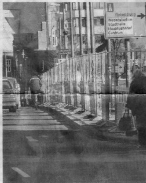
Gefährlich: Fußgänger und Radfahrer auf der Fahrbahn unterwegs in die Altstadt.
