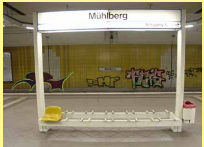
Instandhaltung auf Sparflamme: Die neuen Bänke waren zur Bahnsteigmitte aufgebraucht und für die Demontage wollte man kein Geld ausgeben.
