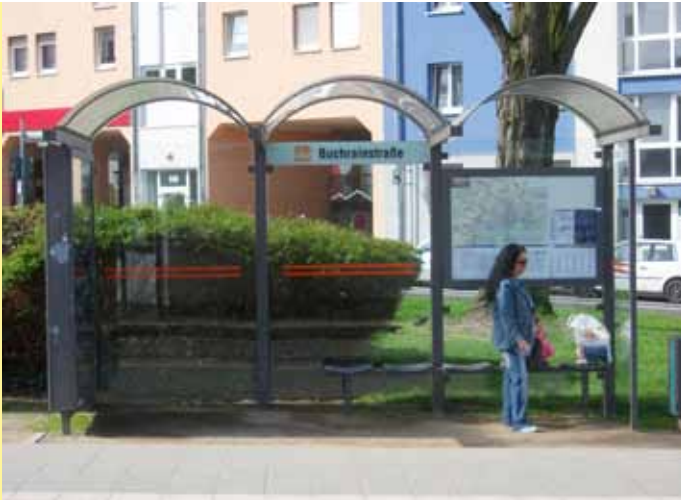
Fahrgastunterstand Typ Tonnendach: Die Sitzbank reicht in den Bereich der Informationsvitrine, die zu hoch angebracht ist.
