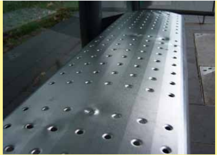
Wie Holzbänke können auch Blechbänke beschädigt werden. Wegen scharfer Kanten ist die Verletzungsgefahr dann aber größer als bei Holzbänken.
