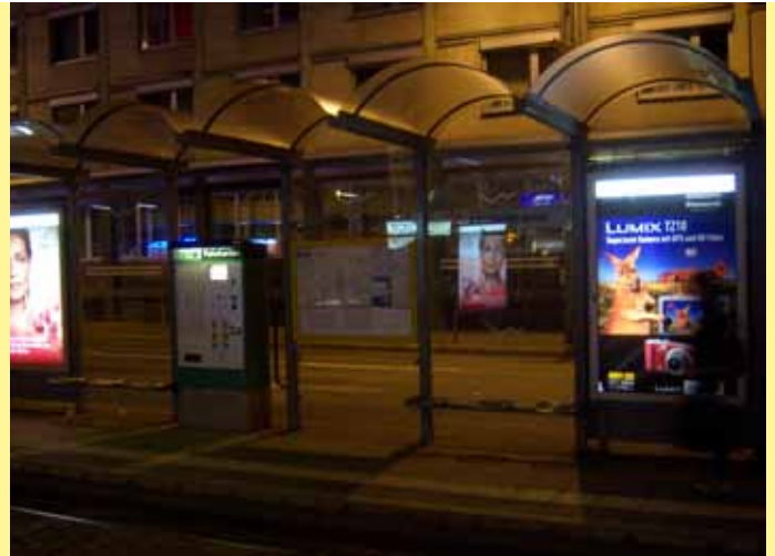
Ohne Deckenbeleuchtung ist der Haltestellenname und bei Ausfall der Vitrienenbeleuchtung auch der Fahrplan nicht zu lesen.
