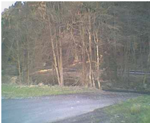
Bild 21: ... an dessen Ende lediglich eine Brücke über die Röhre fehlt, um die Weiterfahrt auf dem Weg zur Kläranlage bis in die Stadtmitte hinein zu ermöglichen! Alte Brückenfundamente sind noch sichtbar...
