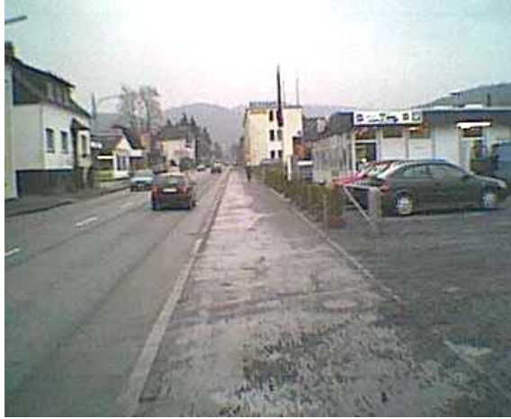
Bild 3: Ortsdurchfahrt Müschede; hier ist die B 229 breit genug zur Markierung von Angebots- oder Radfahrstreifen (s. Bild 4 )
