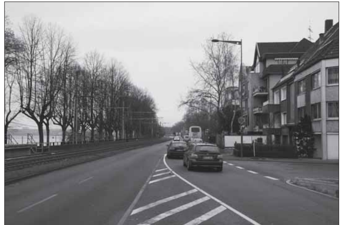
Wenige hundert Meter südlich der zukünftigen Querung wird die Rheinuferstraße einspurig. Diese Engstelle dürfte sicherlich bedeutender sein als eine Sperrzeit-optimierte Stadtbahn-Kreuzung.
