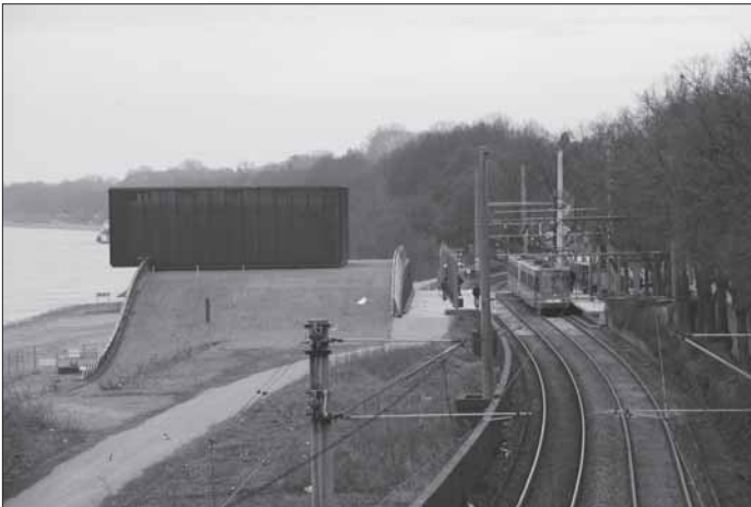
Blick auf die unlängst neu gebaute Haltestelle Schönerhauser Straße. Bei Umsetzung der inzwischen verworfenen Stadtbahn-Tiefelage hätte sie wieder abgerissen werden müssen.
