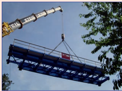
links: Wiederaufsetzen der sanierten Stahlbrücke an der Dilsburger Neumühle
