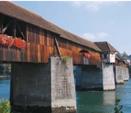
Bad Säckingen, Gedeckte Holzbrücke Foto: Taxiarchos228/Wikipedia
