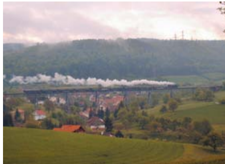
Wutachtalbahn: Zug auf der Talbrücke Epfenhofen, Foto: Schmidt
